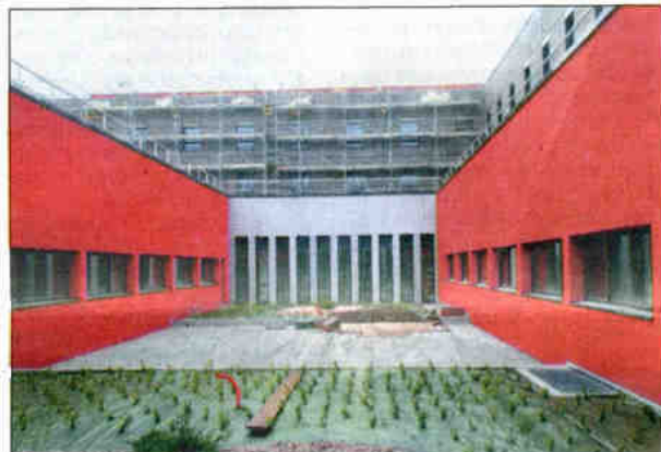
Une vue sur l'un des patios implanté au milieu des bâtiments.
